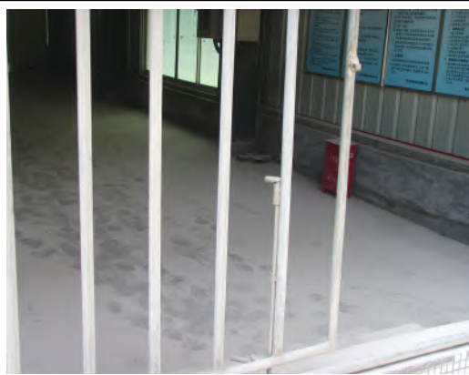
氨罐区大围堰
