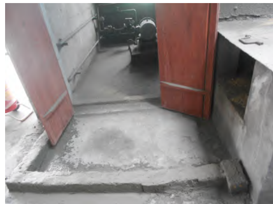
柴油储罐区围堰
