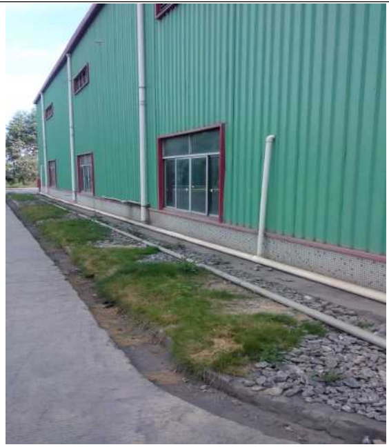
氨罐区应急池管道
